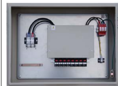
《 DC1000V用 接続箱 ダイオード+主幹端子台タイプ 》
