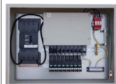
《 DC1000V用 接続箱 ダイオード+主幹MCCB+istring監視タイプ 》
