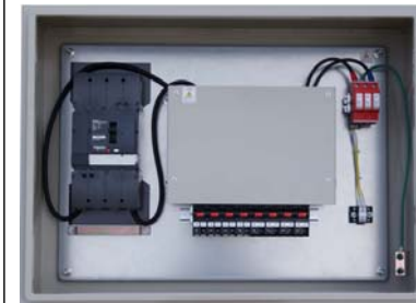
《 DC1000V用 接続箱 ダイオード+主幹MCCBタイプ 》
